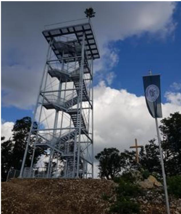
Die „Neue Kaiser Jubiläums-Warte“ wurde 2021 auf dem Eschenkogel errichtet. Die verzinkte Stahlkonstruktion ist 20 m hoch, die 7 x 7 m große Aussichtsplattform ist auf 672 m ü. A. und kann über den flachen Trep- penverlauf gut erreicht werden. Der Rundumblick ist beeindruckend. Ergänzt wird die Anlage durch einen freundli- chen Waldruheplatz mit Chill-Liegen.
